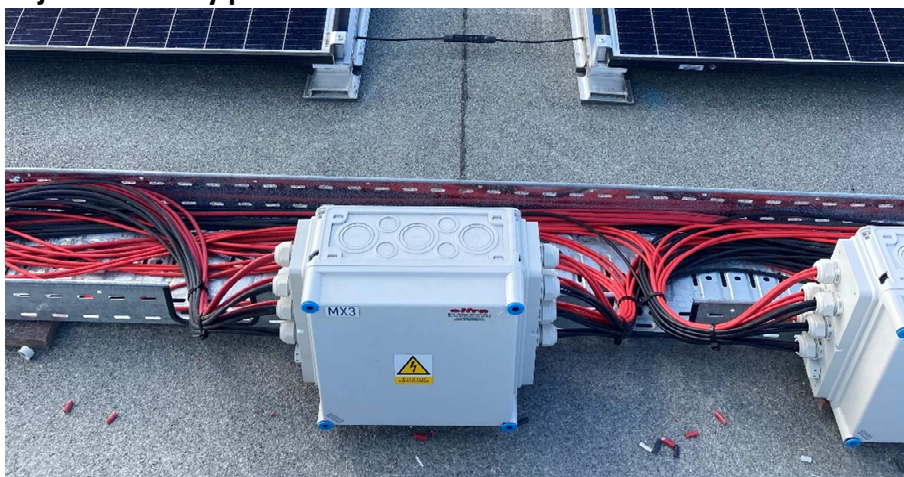
Obrázek 1 Páteřní kabelové vedení v kabelovém žlabu
