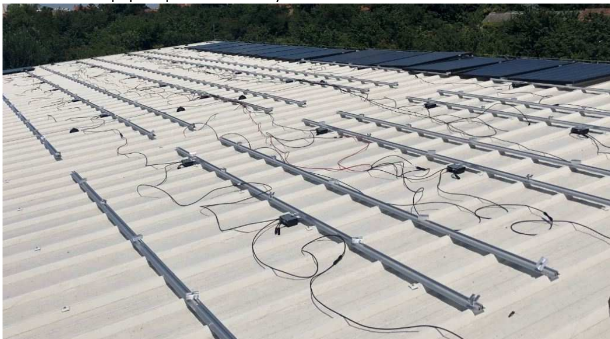
Obrázek 2 Umístění optimizérů pod panely
